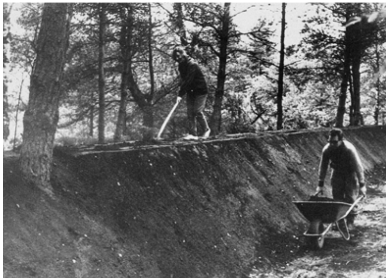
Участники молодежного трудового лагеря во время работ по сооружению земляного вала, 1964 г.
