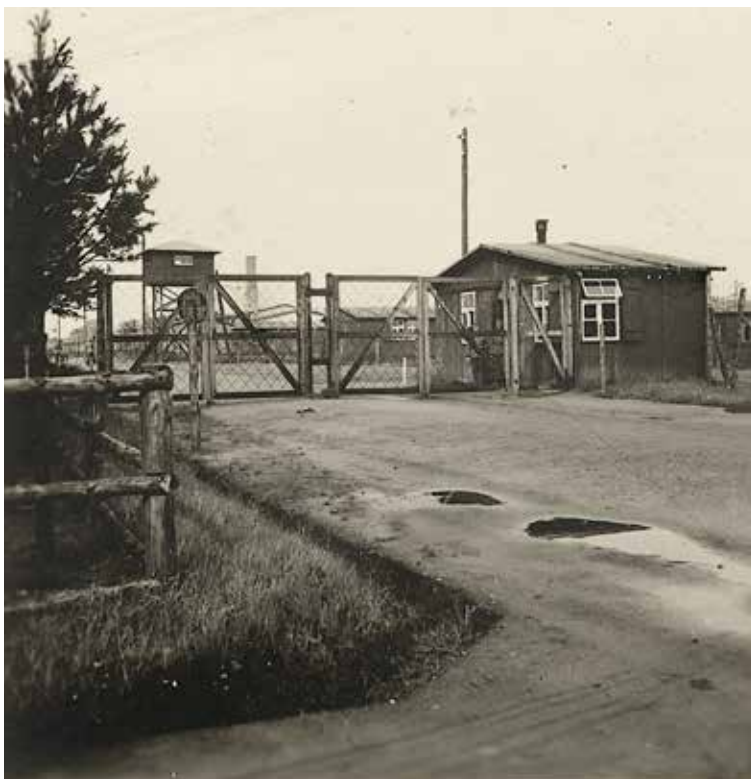
Главные ворота шталага XI С (311), 1942 г. На заднем плане можно распознать трубу здания дезинфекции, построенного только весной 1942 г. Фото из наследия военнослужащего Генриха Ф., работавшего в лагерной комендатуре.
